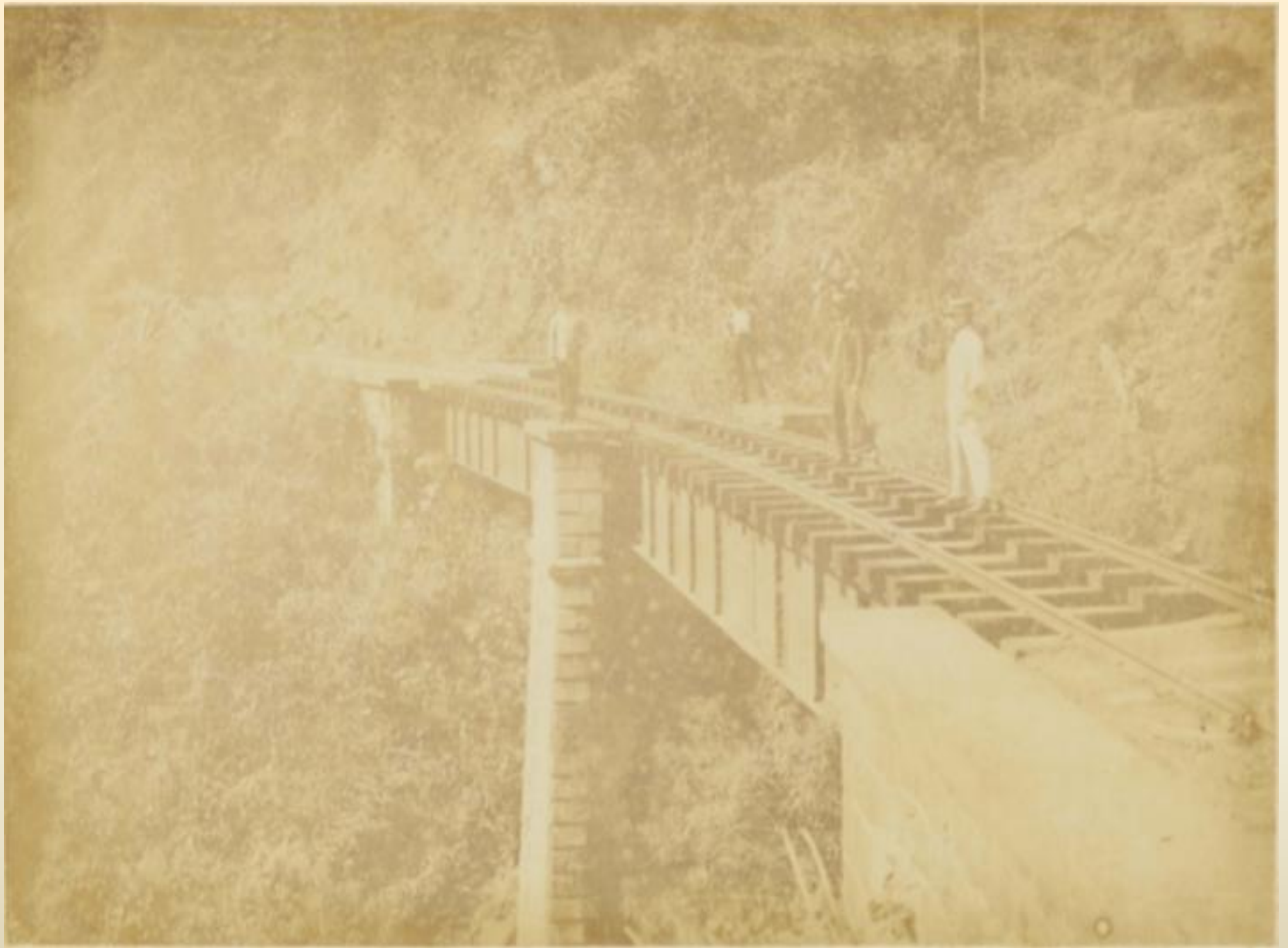
Pontilhão ferroviário situado a 2 km da estação, em direção a Vitória, fabricado pela Schaft and. Axletree. Foto de 1906. Biblioteca Nacional.
